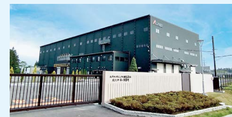
北インター第二事業所 金属精錬工場
