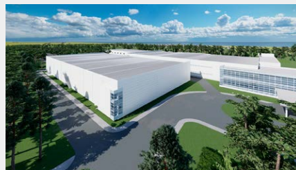
インクジェットプリンター用ヘッド製造の新棟建設を開始 エプソンのグループ会社である東北エプソンに新棟の建設を開始。商業・産業向けプリンターなどの需要の高まりを見込み、生産能力を増強する。 (写真は新棟のイメージ。2025年9月末の竣工を予定。)
