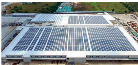
約3,000kWの最大出力を持つメガソーラー発電設備を備えたフィリピンの新工場(2017年)
